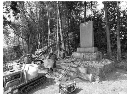
修復作業の様子
